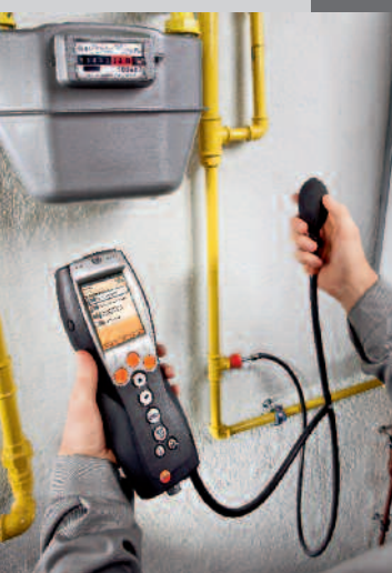
A verificação à instalação de gás
